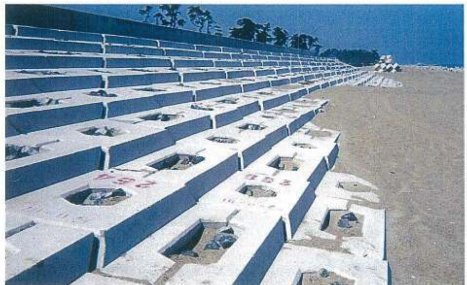
緩傾斜護岸 福島県相双建設事務所 木崎海岸局部改良工事 サーフブロック2TON型 3割勾配にて施工
